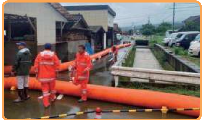
水防工法(大型水のう)
