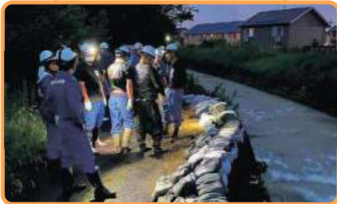
水防工法(土のう積み)
