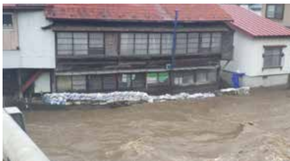
岩手県一戸町消防団 積み土のう工法を実施 (令和2年7月12日～13日:馬淵川左岸)
